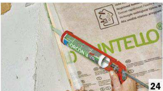
24 Anschluss der Dampfbremsmembran an die Außenwand: Der Kleber sorgt dafür, dass die Folie sicher (hier auf Putz) hält.
