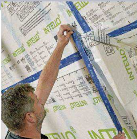
32 Mit weiteren Stücken werden die Laibungsflächen mit der Dampfbremsmembran eingepackt und sorgfältig an allen relevanten Bereichen abgeklebt.
