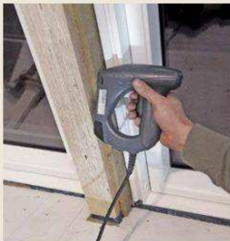
1. Zunächst wird der Hilfssparren aus Mehrschichtholz seitlich gedämmt. Mit dem Tacker hat man dünne, nicht brennbare Steinwolle-Dämmstreifen fixiert.
