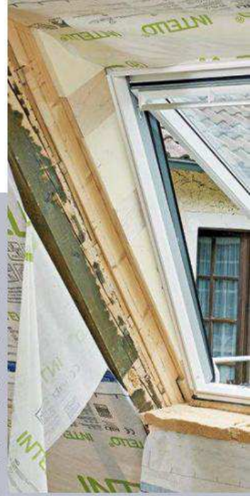
29 Hier wieder einmal die Gesamtsituation: Unten der gedämmte Rohsims rechts und links warten die Laibungen unterhalb der keilförmigen Fensterdämmung auf ihr Dämmmaterial.
