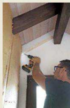
3. Für die späteren neuen Bauplatten hat man noch giebelseitig Traghölzer angeschraubt.
