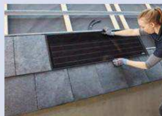
Die nächste Reihe wird halbversetzt angeordnet und überlappt die untere Reihe. Optional lassen sich PV-Module einhängen.
