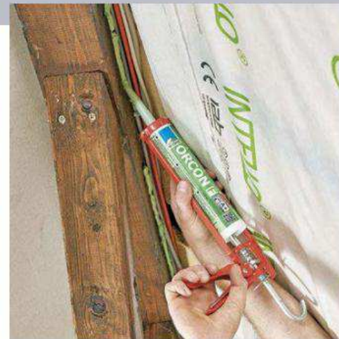
34 Da hier der Firstbalken frei bleiben sollte, muss die Folie an ihm durchgängig angeklebt werden. Dahinter übrigens Elektroleitungen.
