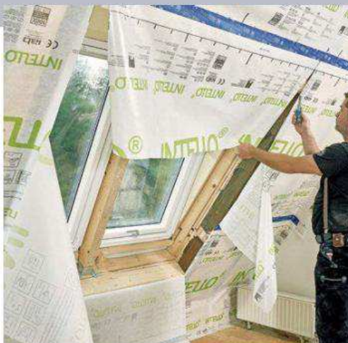
20 Denn Fensterlaibungen, Decke und Sims sollen ja jetzt auch noch gedämmt werden und anschließend ebenfalls unter die Schutzmembran gepackt werden.
