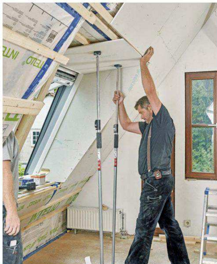
7. Mit passgenau zugeschnittenen Gipsfaserplattenstücken wurden die Gaubenschrägen bekleidet. Die Firstpfette blieb als konstruktives Element in seiner ursprünglichen Form sichtbar.
