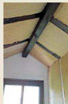
4. Die kleinen Satteldächer wurden sparrentief mit der Holzfaserdämmung verfüllt.
