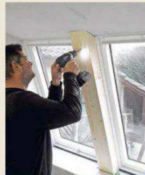
5. Mit zwei kleinköpfigen Schrauben wird das U-Element am Hilfssparren verschraubt, später weiß gestrichen.
