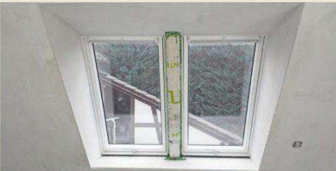
3. ... straff umwickelt und die Folienenden bis in die Nut der Fensterrahmen laufen lassen und dort – sowie oben und unten – sorgfältig abgeklebt. Statt hier auch Gipsfaserplatten als Ummantelung zu nehmen, hat man sich passend zu den weißen Velux-Holzfenstern ...
