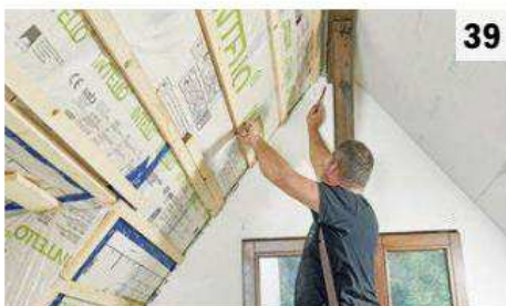
37 Unsere Dämm- und Abklebmaßnahme ist fast beendet. Als nächstes folgt die Beplankung.
