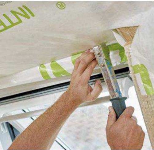
27 Nun kann die Folie am Fenster angeschlossen werden: Den oberen Folienlappen über die Decke ziehen und straff in der Nut antackern.
