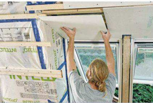
53 Das Ergänzungsstück wurde ebenfalls passgenau zugeschnitten. Manchmal ist es sinnvoll, vor dem Kleberauftrag an der Kante die Formatstimmigkeit zu prüfen.
