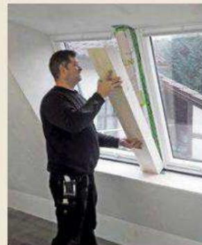
4.... für eine Holzschale entschieden. Diese wurde aus Brettschichtholz vorgefertigt und dann vor Ort noch genau in die Schräge eingepasst.
