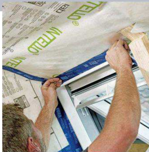
33 Auch wird die Folie am Fenster lückenlos verklebt. Darauf achten, dass die Nut im Fensterrahmen so frei ist, dass hier später die Bauplatten einlaufen können.
