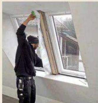
2. Nun muss auch hier für eine dichte Ab-sperrung gegen Raumfeuchte gesorgt werden. Dazu hat man den Balken mit einem Streifen Dampfbremsbahn ...
