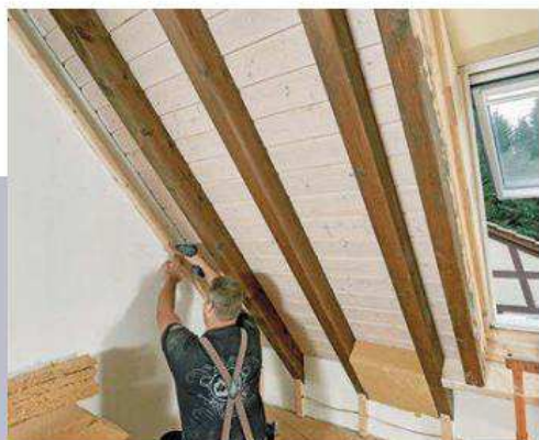
1 Das Sichtsparrendach mit außenliegender Profilbrettschalung sollte von innen nachgedämmt werden. Das neue Kantholz dient später der Plattenauflage.
