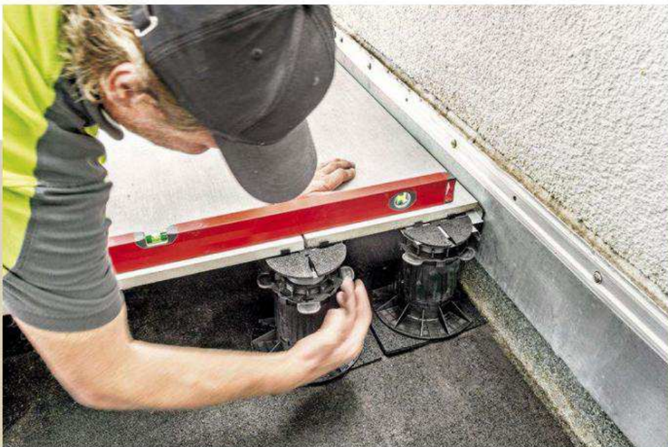
22 ... automatisch ein - bei sauberem Zuschnitt der Randplatten. Letzte Kontrolle dann noch von Platte zu Platte. Gegebenenfalls lässt sich noch etwas nachjustieren.
