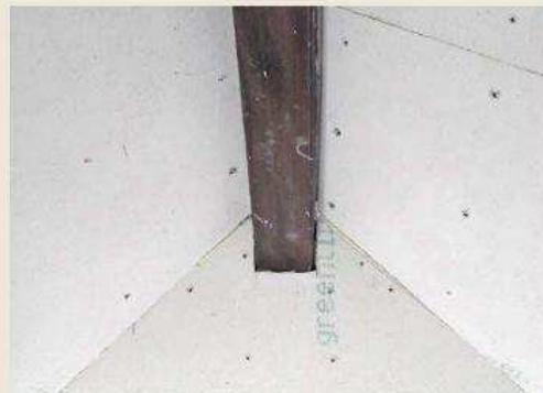
7. Mit passgenau zugeschnittenen Gipsfaserplattenstücken wurden die Gaubenschrägen bekleidet. Die Firstpfette blieb als konstruktives Element in seiner ursprünglichen Form sichtbar.
