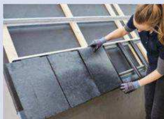
Die Schieferplatten sind dann schnell eingelegt und bilden in einer Reihe eine eindimensionale Dachfläche mit Fugenraster.
