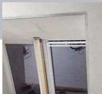
53 Das Ergänzungsstück wurde ebenfalls passgenau zugeschnitten. Manchmal ist es sinnvoll, vor dem Kleberauftrag an der Kante die Formatstimmigkeit zu prüfen.
