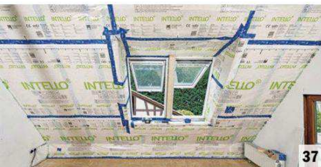
32 Mit weiteren Stücken werden die Laibungsflächen mit der Dampfbremsmembran eingepackt und sorgfältig an allen relevanten Bereichen abgeklebt.
