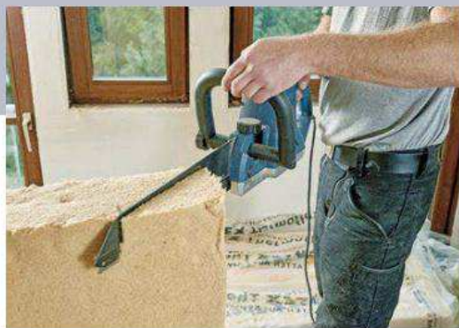
5 Die unteren Elemente wurden gemäß der Dachneigung angeschrägt. Hierfür eignet sich ein Elektrofuchsschwanz, der spielend leicht durchs zähe Holzfasermaterial kommt.
