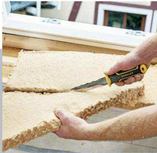
28 Der Sims und die Laibungsseiten erhielten noch Dämmstoffauflagen aus 4 cm Material, das hier auch einmal mit einem Handmesser zurechtgeschnitten wurde.
