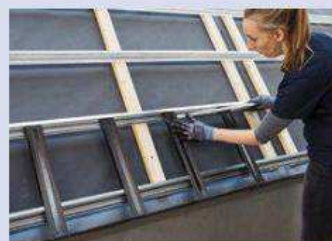
Im Weiteren geht es um das Einmessen der wasserführenden Verbindungselemente im entsprechenden Montageabstand.
