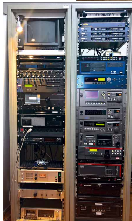
Der Geräteturm ist beachtlich. Über 10.000 Watt geben allein die Endstufen aus, um die zahlreichen Lautsprecher anzutreiben
